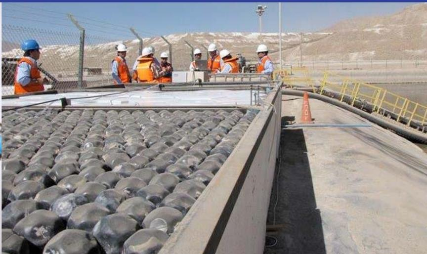
**Patente CL 2389-2011. Invención denominada Sistema Integrado para mitigar las pérdidas de agua y medición automatizadas de tasas de evaporación en piscinas o estanques de uso minero**
